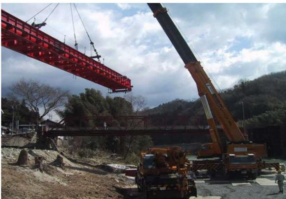
比較的人による組み立て要素が強く工事が長期化する鋼橋架設工事に対し、特許を取得した同社独自の資材、機材を活用しながら一式施工により無駄、無理をなくし工事を円滑に進めており、この鋼橋工事の技術をいかし、特殊な工事にも対応を可能としている。
