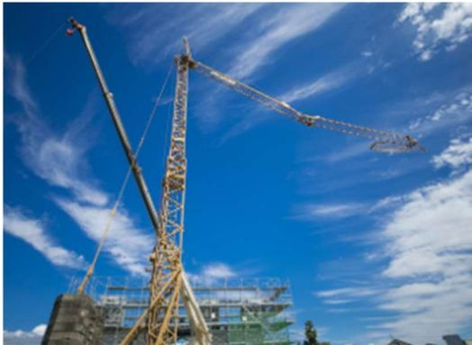
同社グループクレーン設備レンタル事業では、欧米・アジア圏など世界中でメジャーに活用されており、コスト・効率・安全性など様々な面でメリットが大きく、日本国内でも新たな選択肢として注目が集まっている定置式水平ジブクレーンを中心にクレーン設備を全国の工事現場へ提供して
