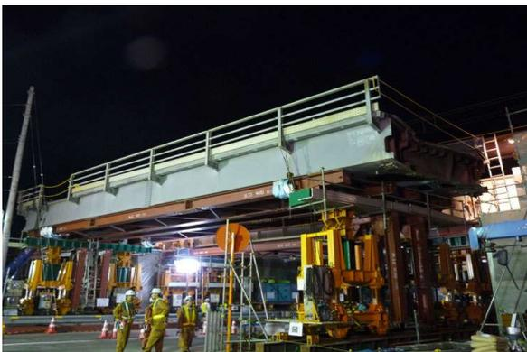
工事が大規模化し、PC 桁 1 本当たりの重量も最大で 200t を超えるものがあるコンクリート製桁の架設工事に対し、同社の総合力を発揮し、施工方法の計画や独自の新機材、工法の開発など技術力向上を図りながら対応している。
