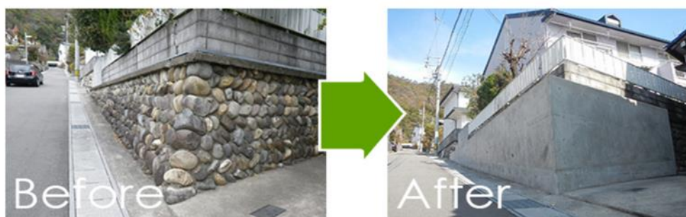
【造成工事の施工実績】
