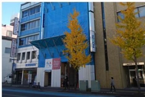
【建築工事業の施工実績】
