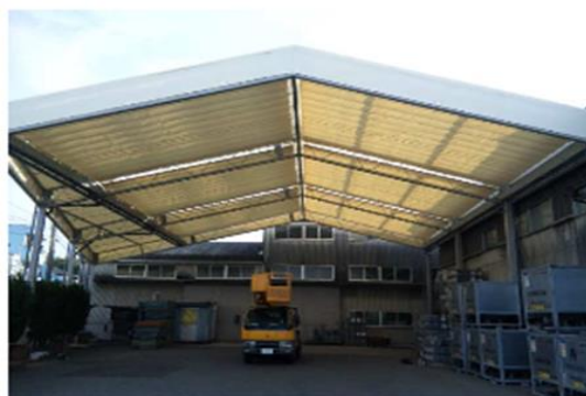
【透光性のある上屋の施工事例】
