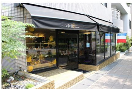
【デザイン性の高いオーニング施工事例】
