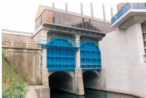
新犀川排水樋門（岐阜県安八町）
