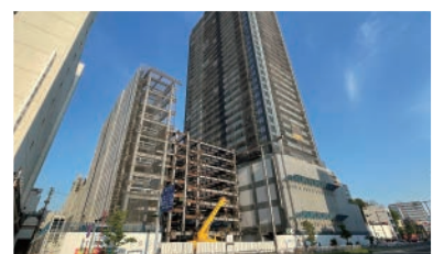
「柳ヶ瀬グラッスル35」建設風景 (高島屋南市街地再開発組合 提供)
